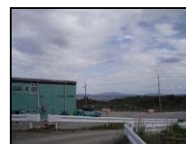
竹富町リサイクルセンター
